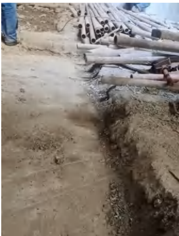
图 6.2.2- 1 新老筏板施工完成后情况
