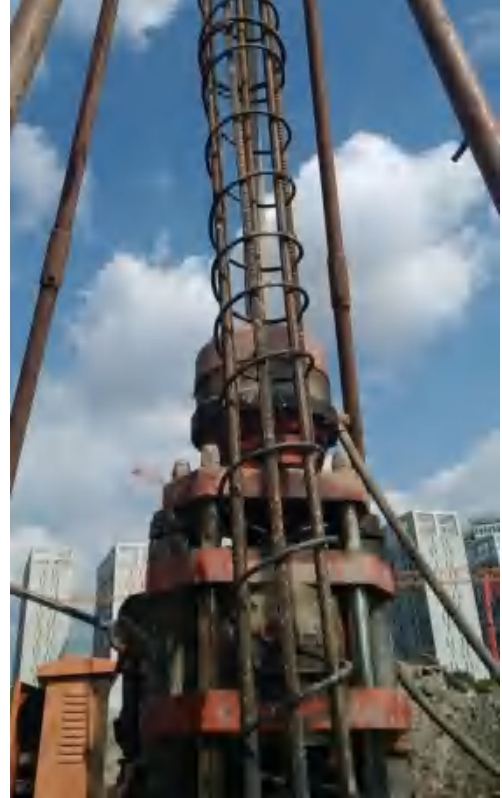
图 4.3.2- 33 树根桩施工
