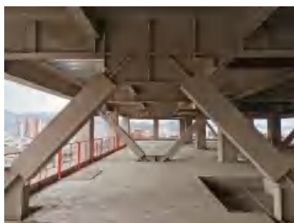
图 4.1.2-6 屈曲约束支撑实物安装图
