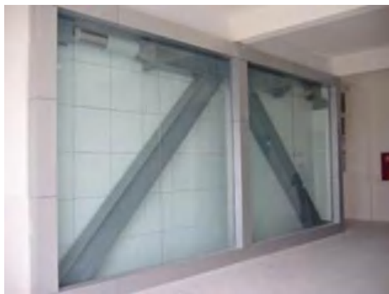
图 4.1.2- 10 黏滞阻尼器支撑实物安装图
