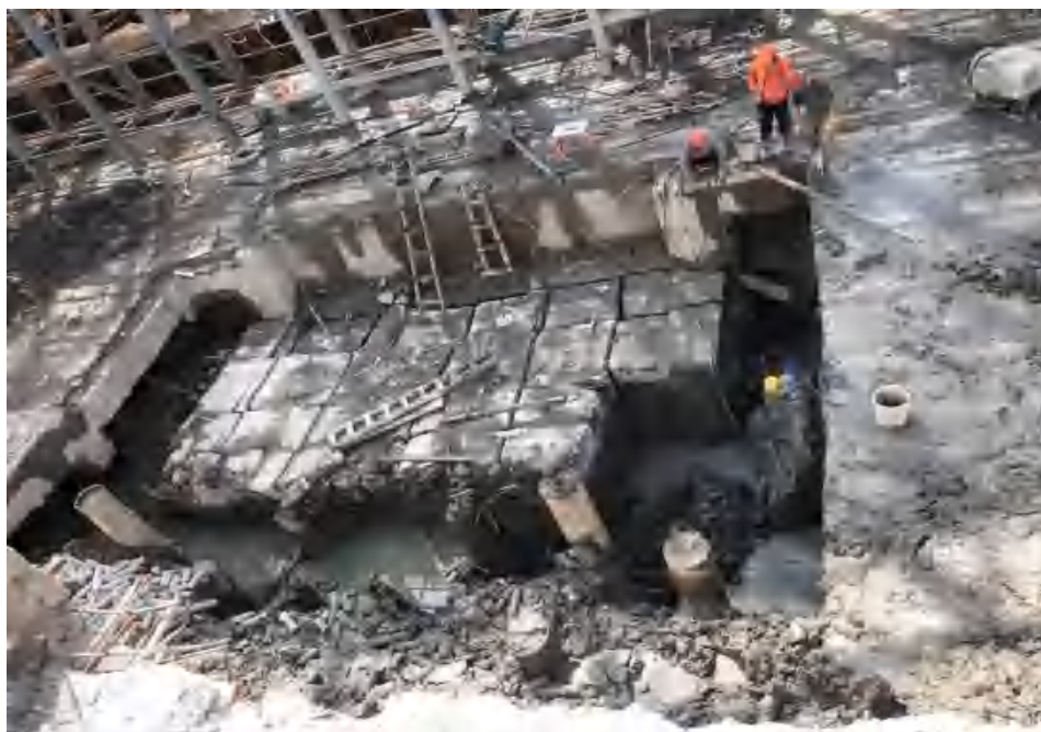
图 4.3.1- 3 核心筒基坑工况图
