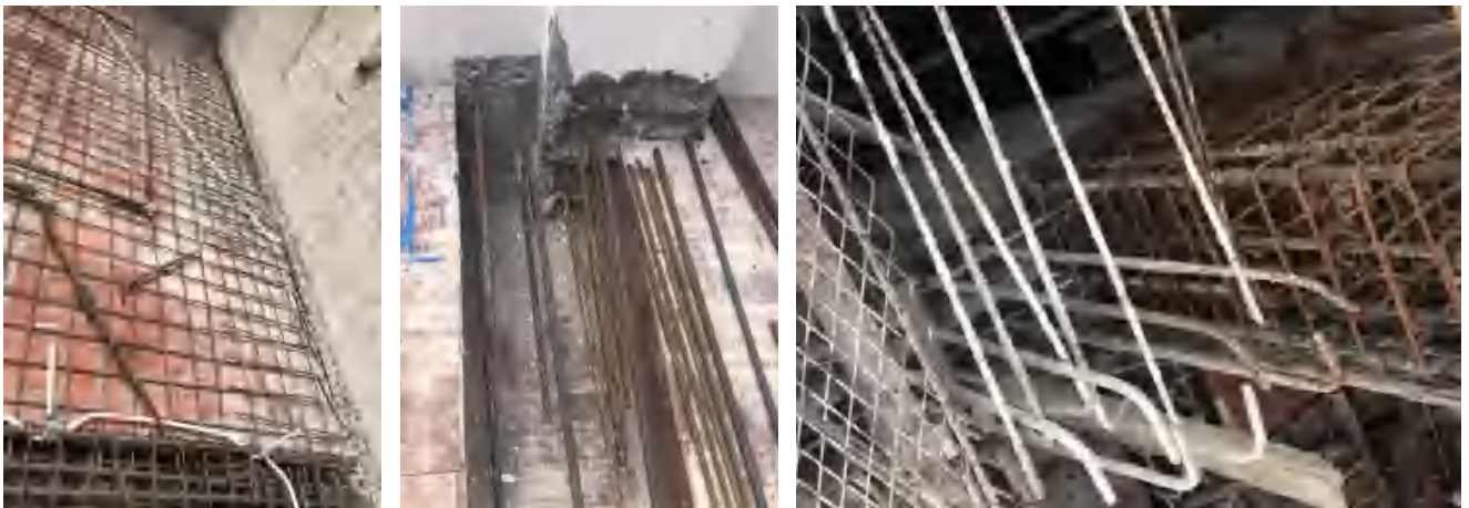
图 4.2.3- 2 T2 户型原地下室一层新增夹层, 植筋与局部接高
