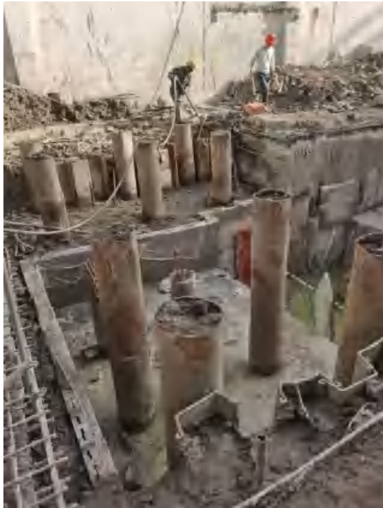
图 4.3.1-3 原电梯井结构移位施工
