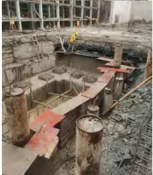
图 4.3.1-3 原电梯井结构移位施工
