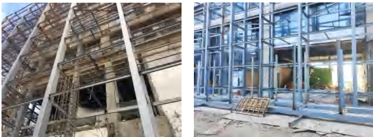
图 4.1.1- 16 原建筑物非承重构造拆除
