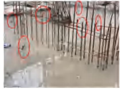
图 4.2.2-27 浇筑新筏板，预留注浆管
