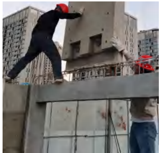
(b) 墙板的安装一
