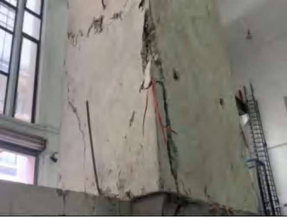
(g) 柱扩散角混凝土剥落
