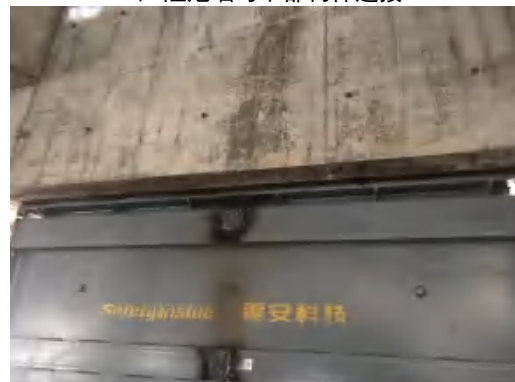
c) 阻尼墙与上部结构连接
