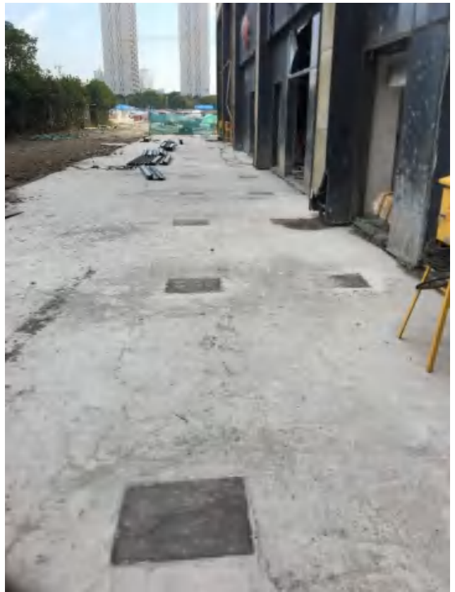
图 4.3.2- 34 钢外架预埋基础
