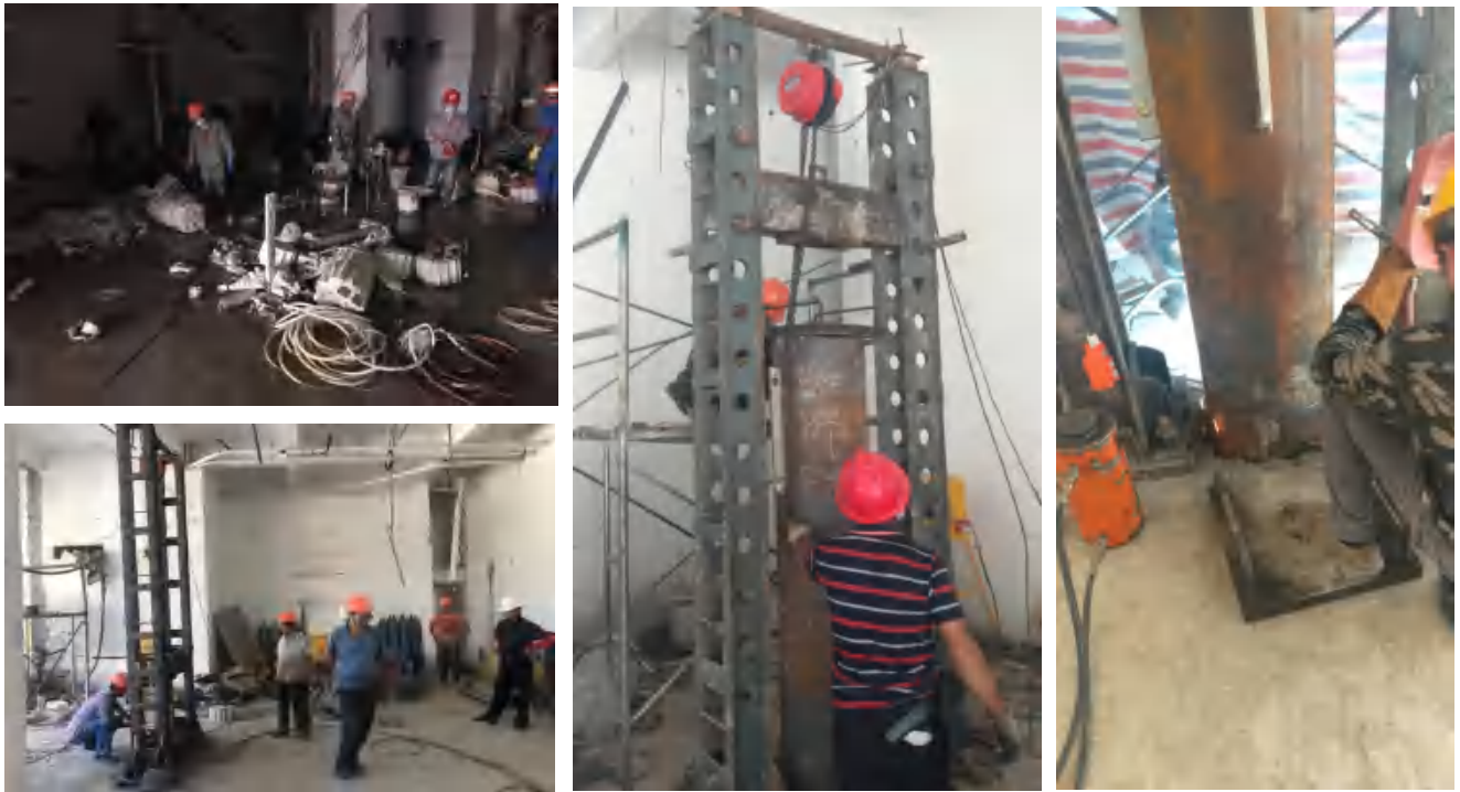
图 4.2.1- 10 在拆除原建筑物前，在保留筏板上开孔，进行钢管桩补桩
