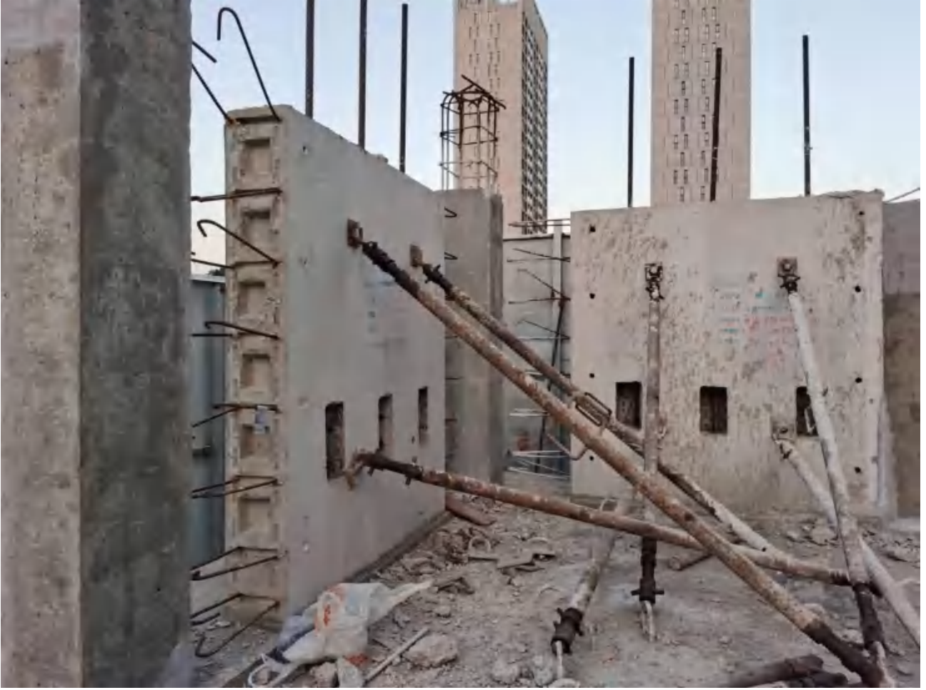
图 4.4.5- 4 现场样板施工
