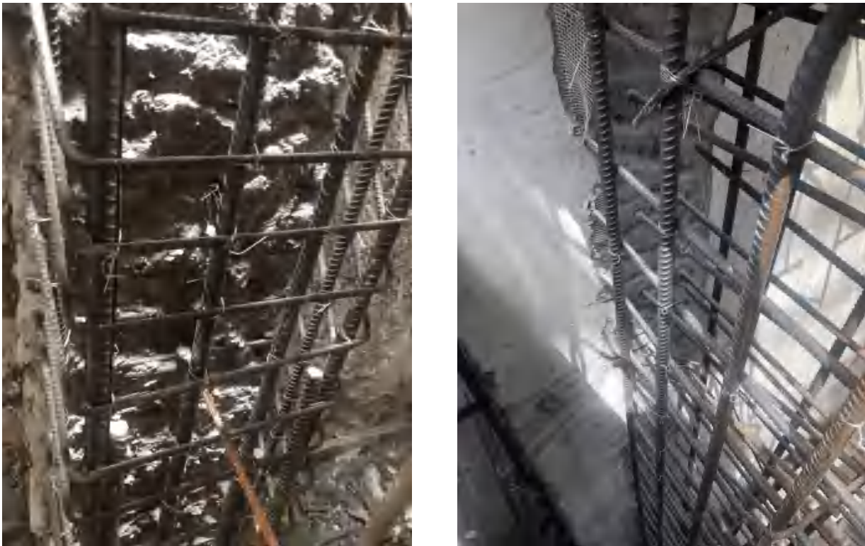
图 4.1.1- 20 T2 户型保留柱加强，保留结构与新结构连接
