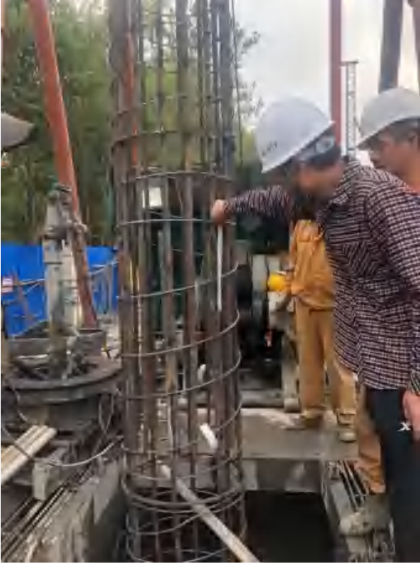
图 4.3.2- 33 树根桩施工
