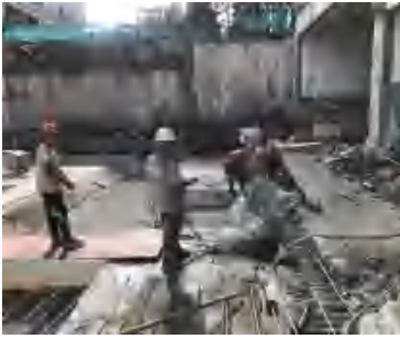
图 4.2.2-25 混凝土凿除
