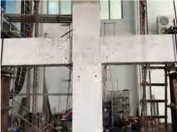
(e) 核心区出现新裂缝，柱扩散角产生裂缝
