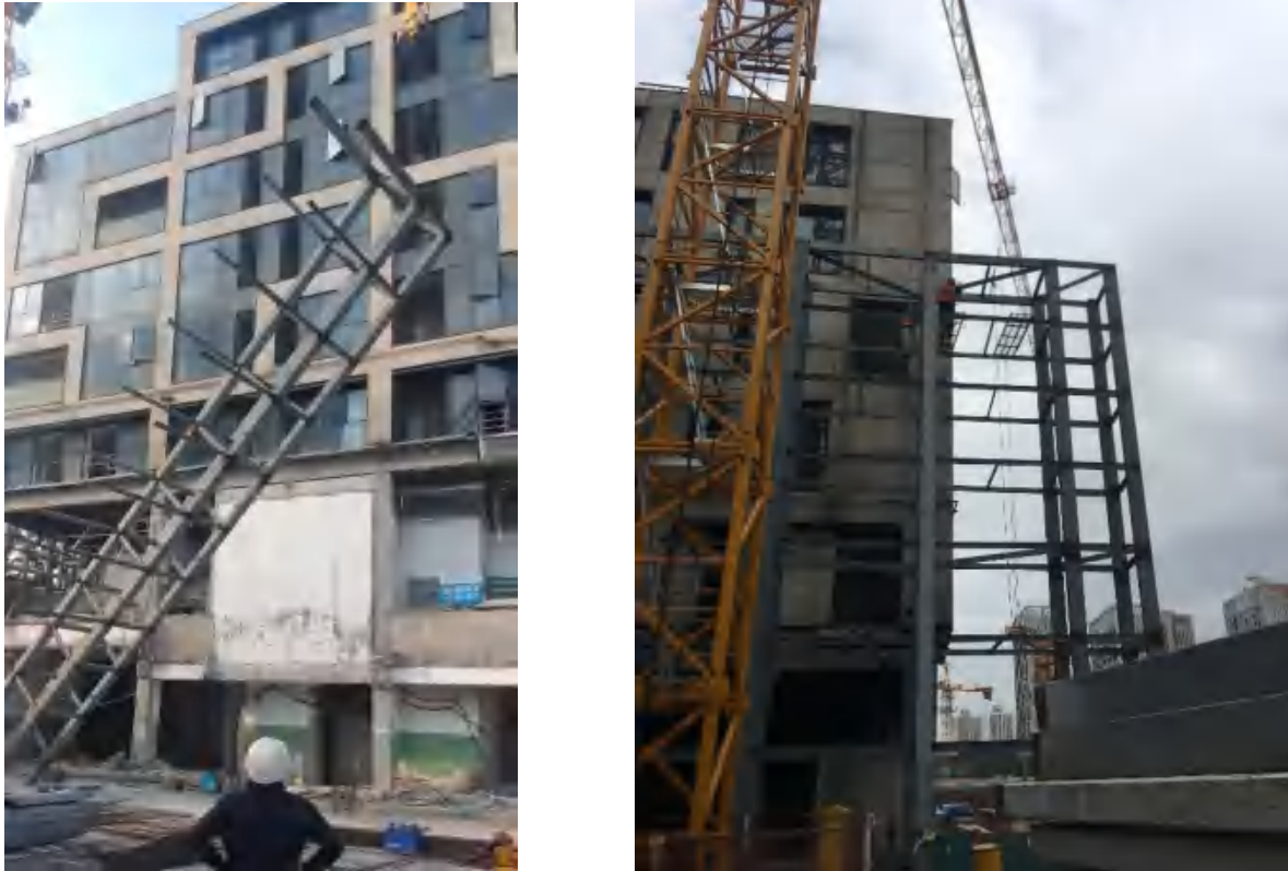
图 4.3.2- 35 钢外架安装
