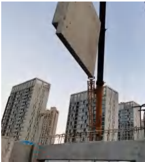
(a) 墙板的吊装
