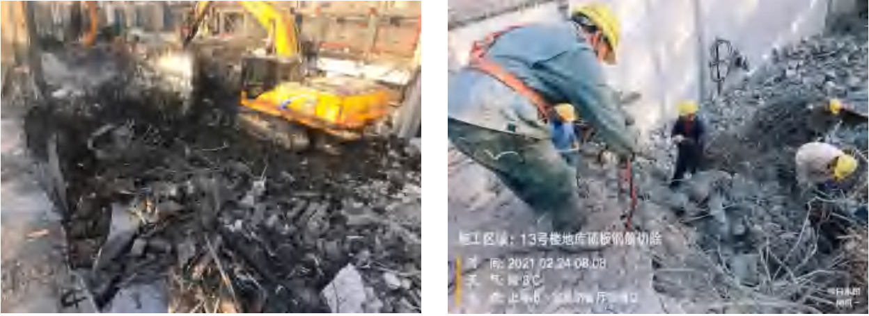
图 4.1.1- 17 T2 户型原有建筑拆除，保留外部框架结构
