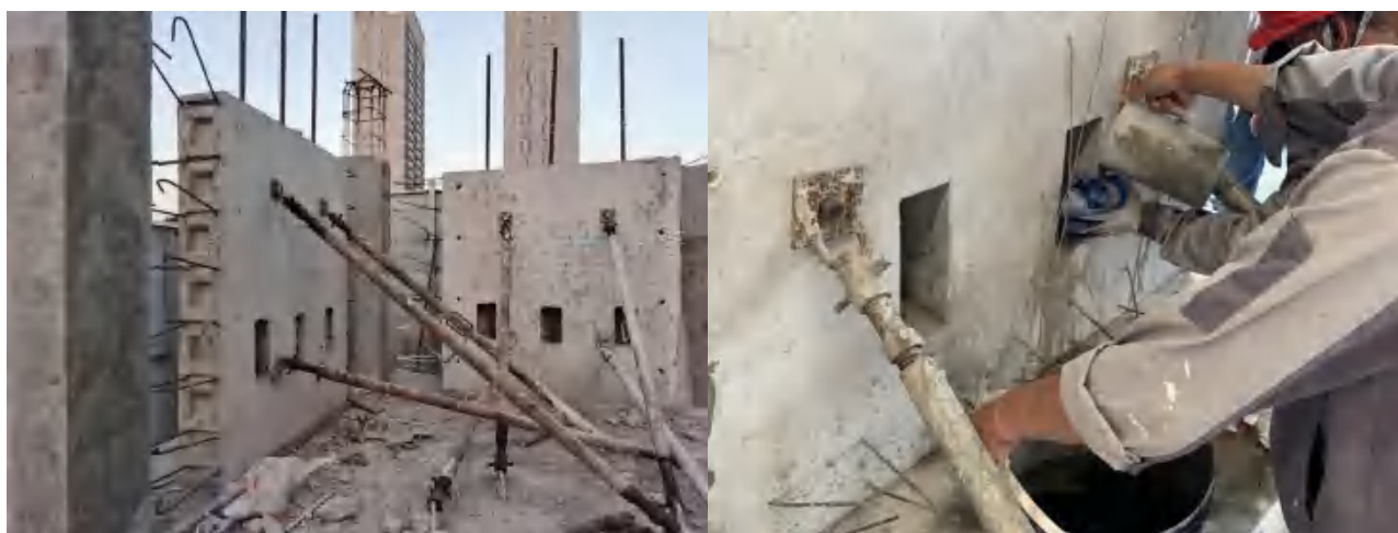
图 6.2.4- 2 剪力墙新型节点施工
