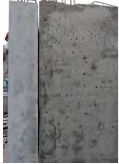
(d) 安装就位后的墙板
