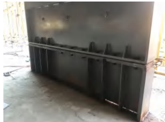
b) 阻尼墙与下部构件连接
