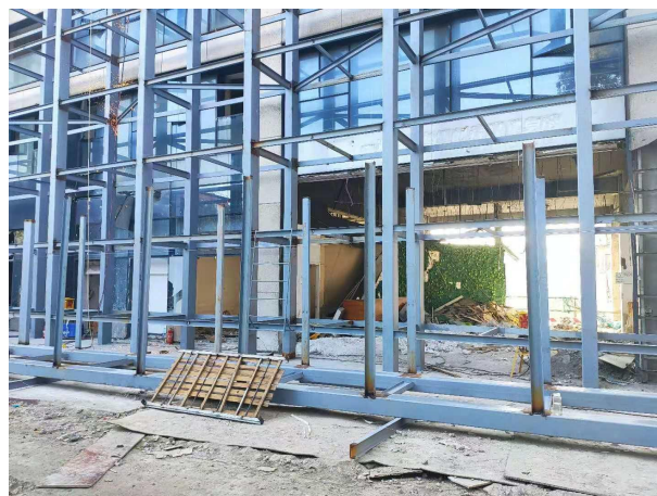
图 4.1.1- 16 原建筑物非承重构造拆除
