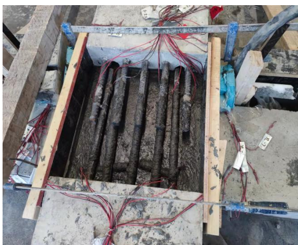
(d) 核心区浇筑 UHPC
