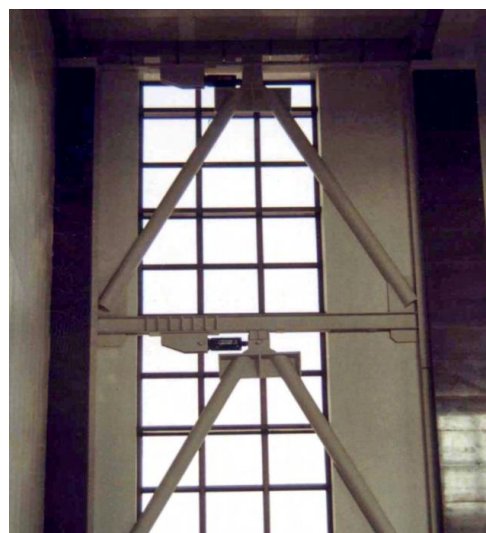
图 4.1.2- 16 北侧支撑立面效果
