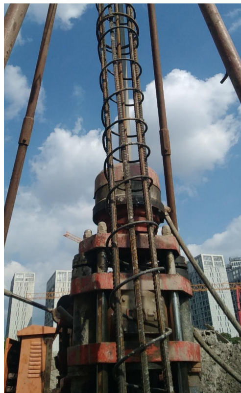
图 4.3.2- 33 树根桩施工
