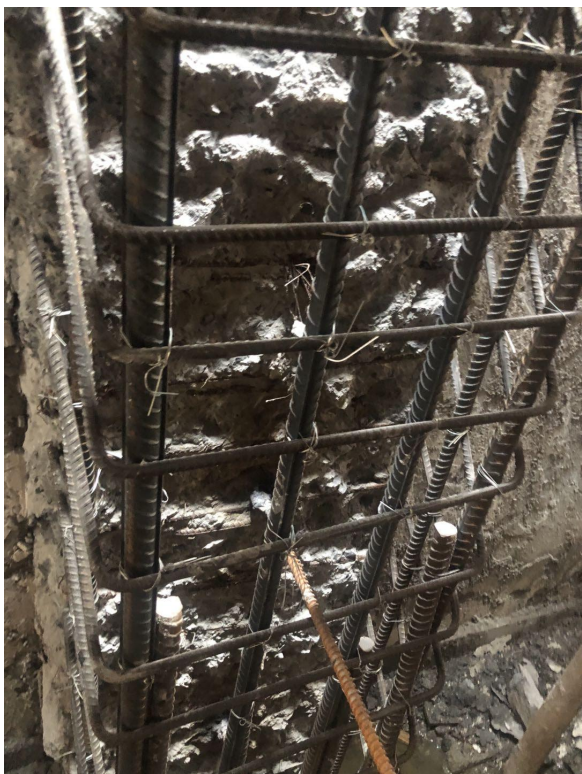
图 4.1.1- 20 T2 户型保留柱加强，保留结构与新结构连接
