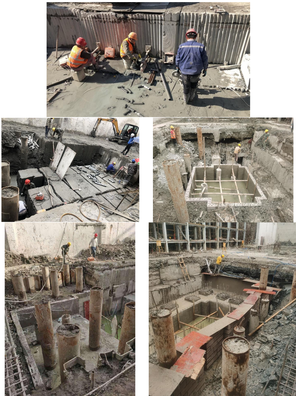
图 4.3.1- 3 原电梯井结构移位施工
