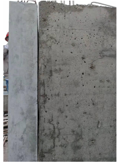
(d) 安装就位后的墙板
