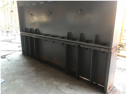
b) 阻尼墙与下部构件连接
