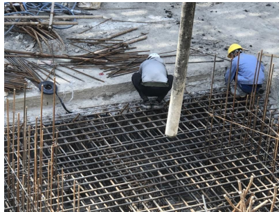
图 4.2.2-26 贴遇水膨胀止水条
