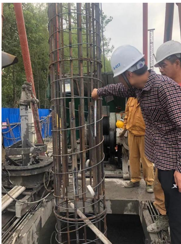
图 4.3.2- 33 树根桩施工
