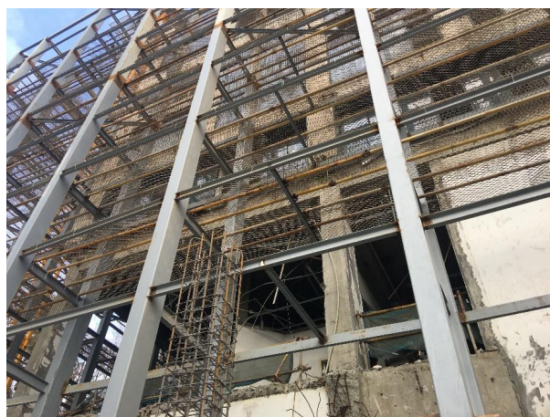
图 4.1.1- 16 原建筑物非承重构造拆除
