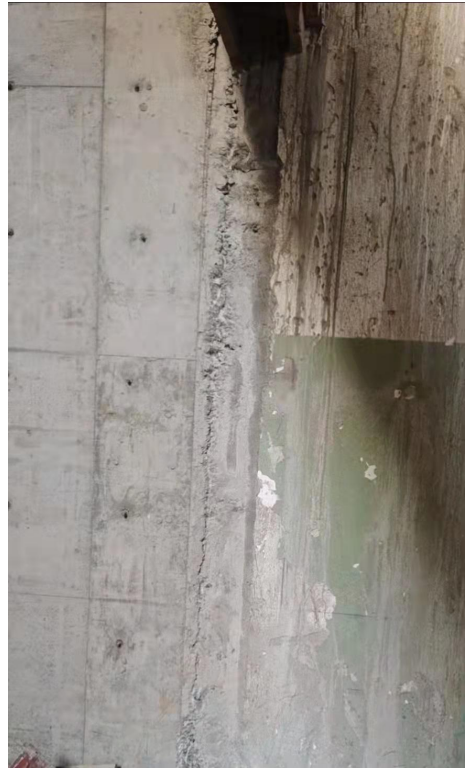
图 6.2.2- 2 新老外墙施工完成后拆模时情况
