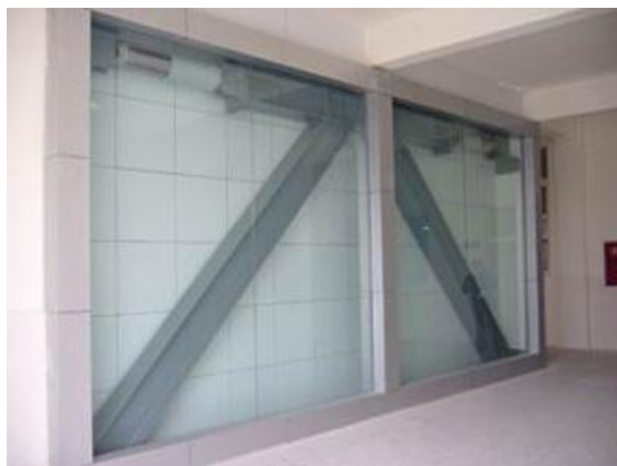
图 4.1.2- 10 黏滞阻尼器支撑实物安装图
