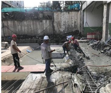
图 4.2.2-25 混凝土凿除
