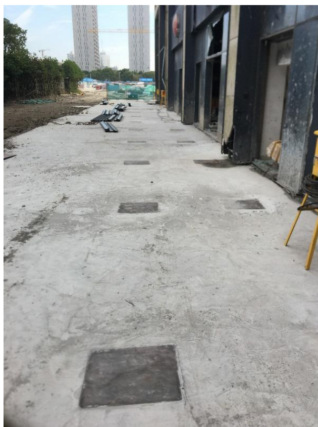
图 4.3.2- 34 钢外架预埋基础
