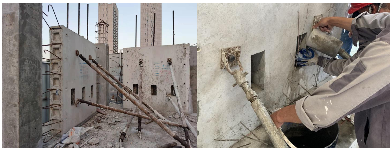
图 6.2.4- 2 剪力墙新型节点施工
