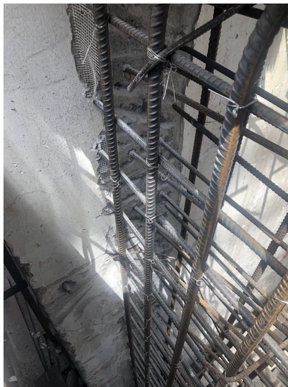
图 4.1.1- 20 T2 户型保留柱加强，保留结构与新结构连接
