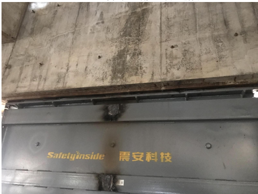
c) 阻尼墙与上部结构连接
