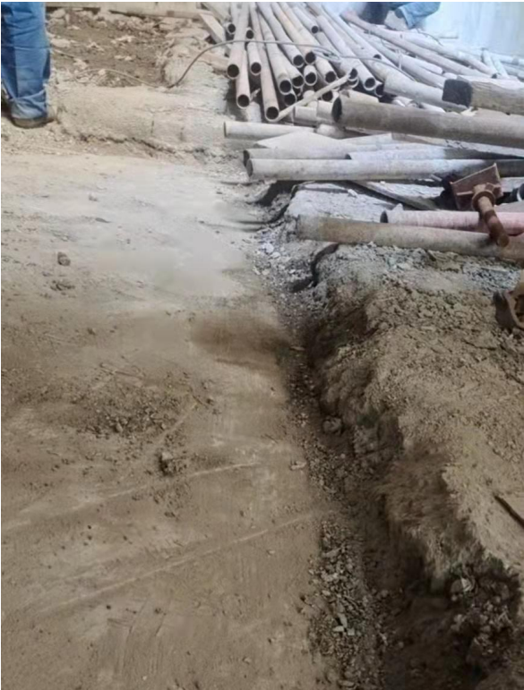
图 6.2.2- 1 新老筏板施工完成后情况
