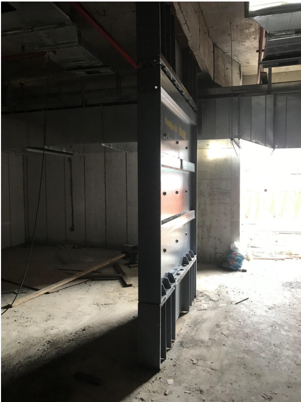
a) 阻尼墙整体安装照片
