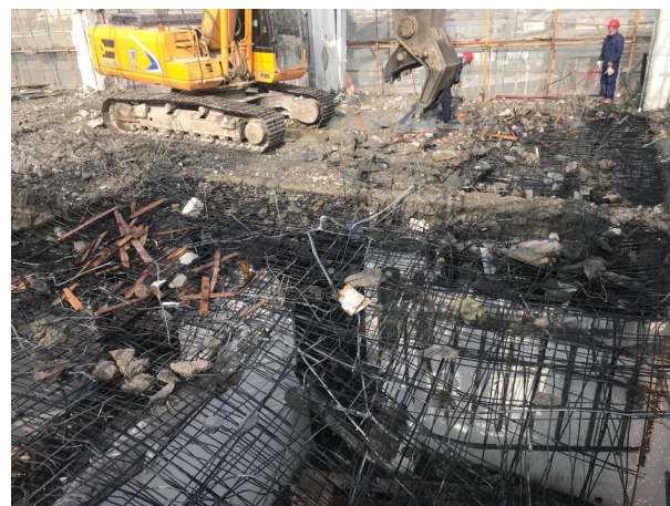
图 4.1.1- 16 原建筑物非承重构造拆除
