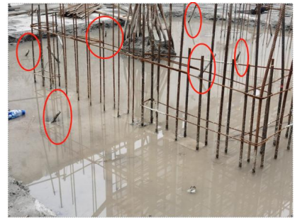
图 4.2.2-27 浇筑新筏板，预留注浆管
